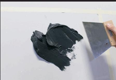
Das Material gleichmäßig mit dem Zahnpachtel oder der Zahnkelle so auftragen, dass der Untergrund vollständig bedeckt ist.
