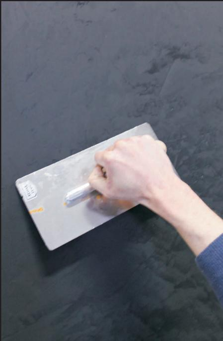
Den Magnetspachtel nach ca. 110-150 Minuten glätten und bügeln. Das bedeutet: Die Oberfläche mit etwas Druck verpressen. Der Spachtel hat in dieser Phase abgebunden, ist aber noch nicht vollständig durchgehärtet.
