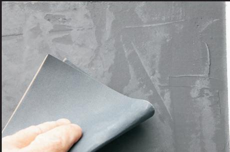
Nach 24 Stunden mit Körnung 360 leicht schleifen. Dadurch erhält man eine besonders glatte Oberfläche. Farbschattierungen werden angeglichen.
