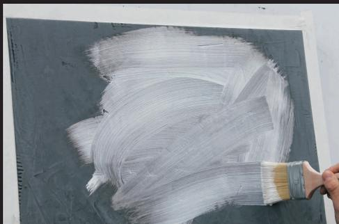
Die Ränder erneut abkleben. Die Lasur (hier Rauchquarz) mit dem Pinsel satt auftragen und direkt anschließend mit dem Japanspachtel abziehen. Abschnittsweise arbeiten.
